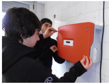
Instalación del inversor.
