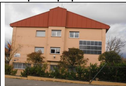
Ubicación de paneles.
