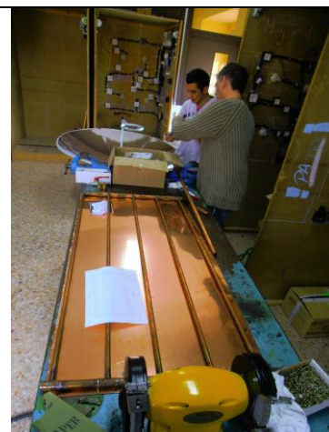
Fabricación del panel para calentamiento de agua.
